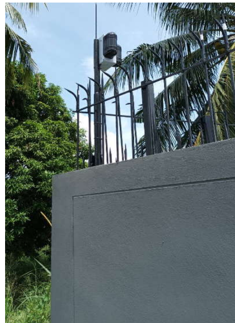
ตัวจับสัญญาณภายนอก Beam Photo (แนวรั้ว)
