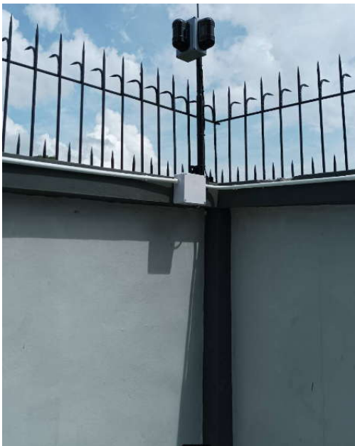
ตัวจับสัญญาณภายนอก Beam Photo (แนวรั้ว)
